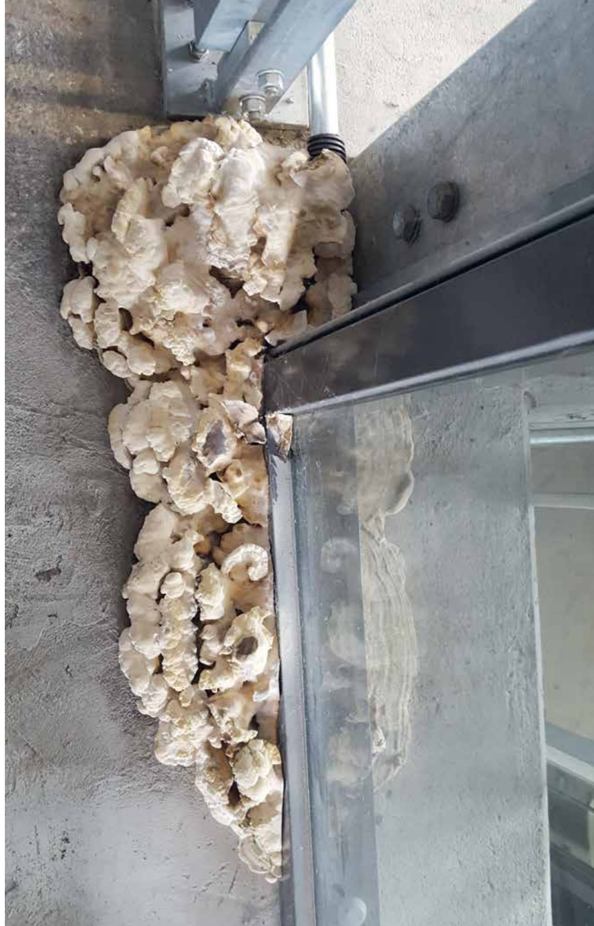
Pilzbefall in einem unklimatisierten Ausstellungsraum im Historisch-Technischen Museum Peenemünde (Foto: Historisch-Technisches Museum Peenemünde)
