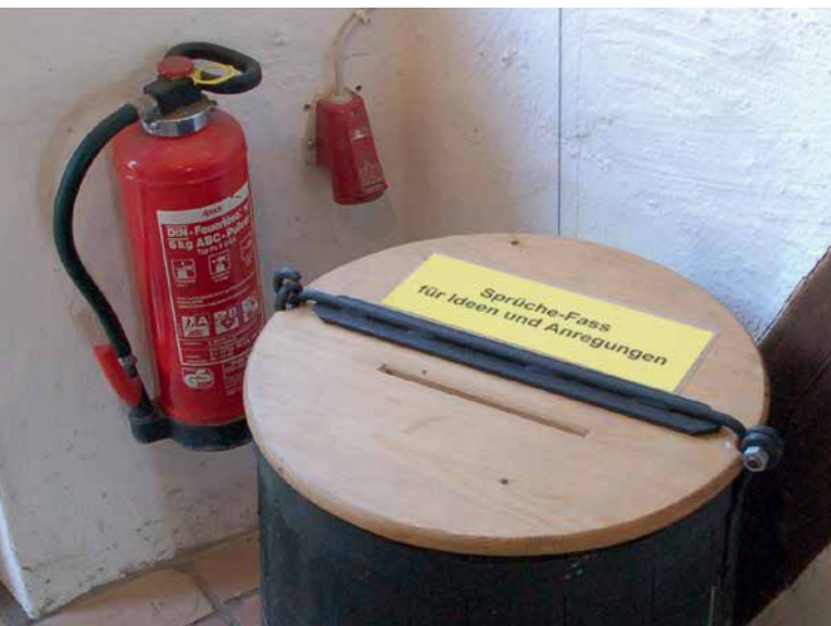
Feuerlöscher müssen auch für Besucher erreichbar bleiben (Foto: W. Karge)
