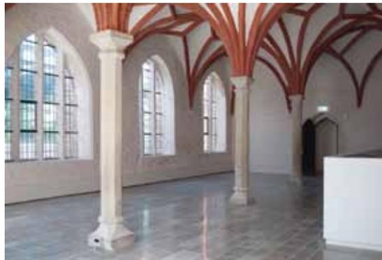
Sanierter Raum mit Kalksteinfußboden und restauriertem Gewölbe, rechts eine Rampe für barrierefreien Zugang
